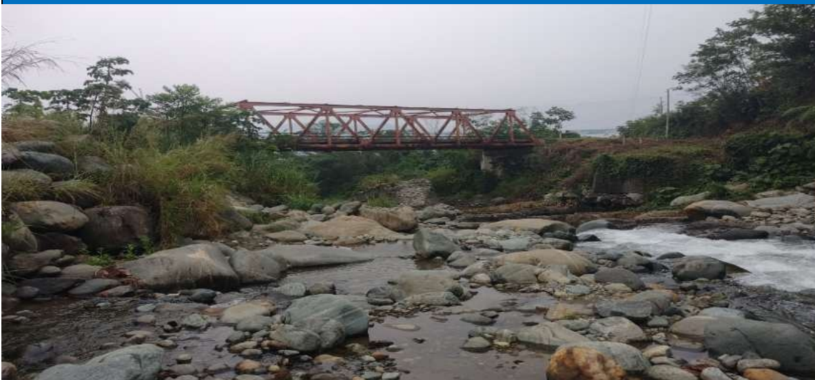
FIGURA N°01: VISTA DE PUENTE CHIRUMPIARI, VULNERABLE A SOCAVACIÓN POR PARTE DEL INCREMENTO DEL CAUDAL DEL RÍO CHIRUMPIARI
